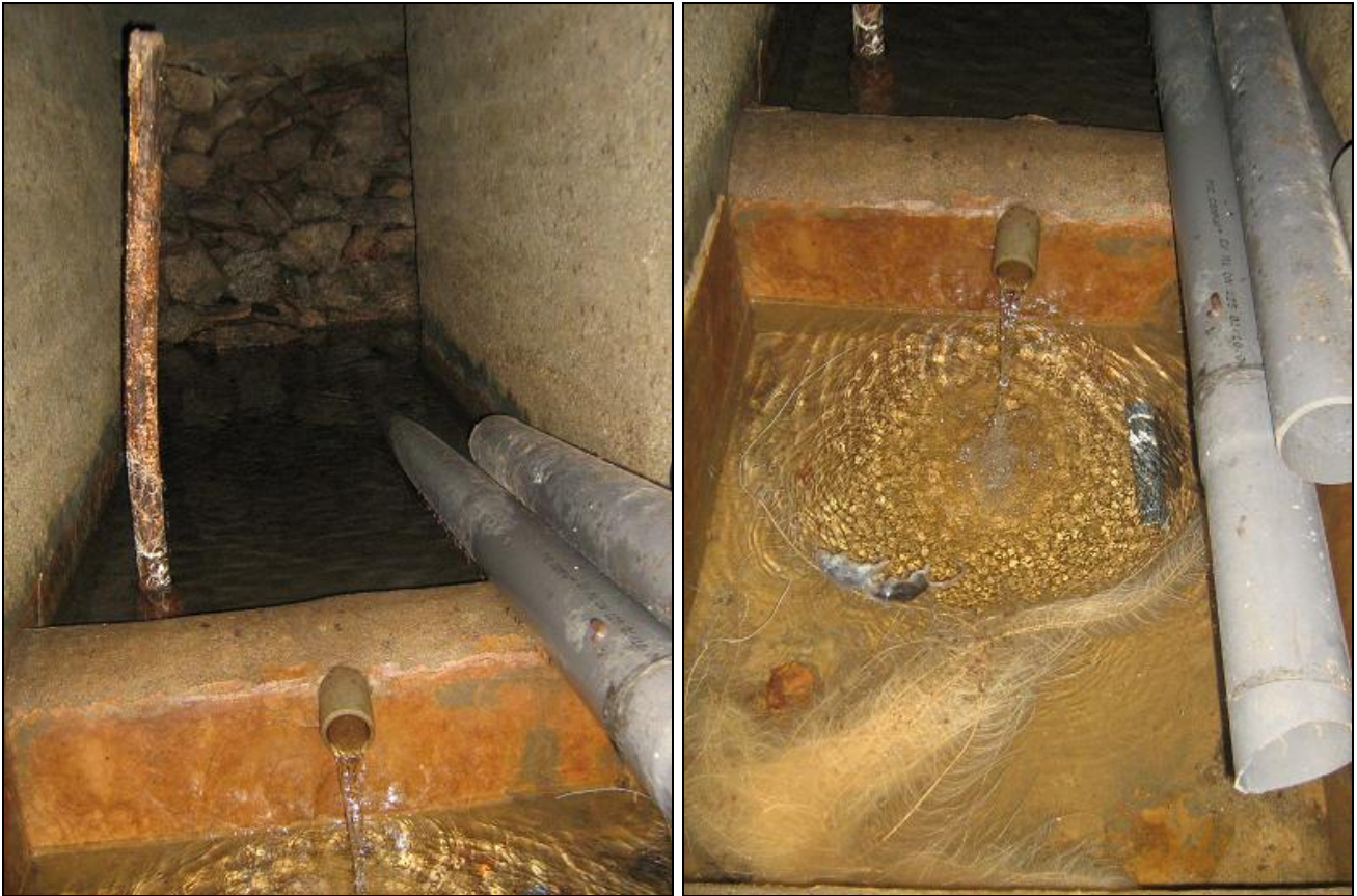
Figure 6 – Captage de Fontalard (intérieur : source au fond et décanteur au premier plan)
