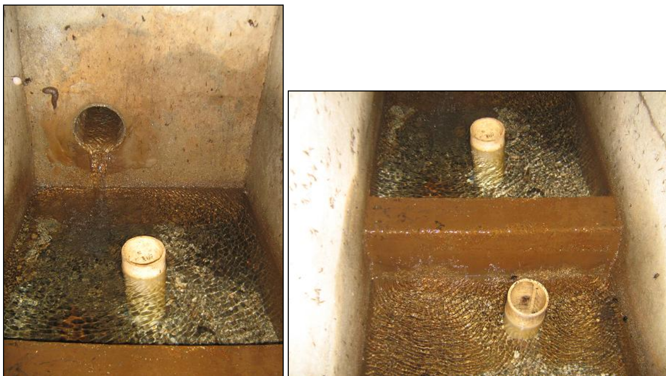
Figure 9 – Captage de l'Adret de Grimal (arrivée de l'eau au fond et décanteur)
